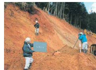
(急傾斜地崩壊対策)
