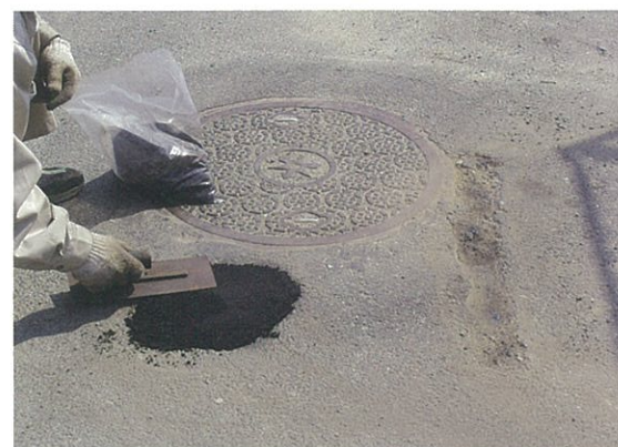
④敷き均し(金ゴテ)
