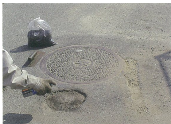
②タックコート施工(アスファルトスプレー)
