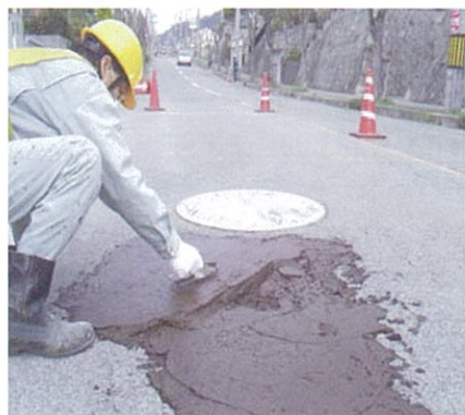
Uコートタフ施工状況
