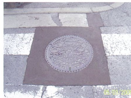
マンホール周囲のくぼみの補修からゼロすり付けまでの対応が可能です。
